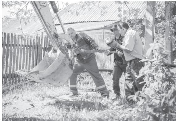
Но всё это будет согласовано в конечном итоге, а так уже по большей части весь трубопровод проложен. Работы массовые, так сказать, закончились, остались работы сложные – проколы, стыки. Сейчас в Ржеве освободится установка наклонного бурения и начнётся прокладка трубопровода через Волгу. На всякий случай будут проложены две линии, чтобы при необходимости можно было переключиться на запасную. А дальше начинается самое интересное...
