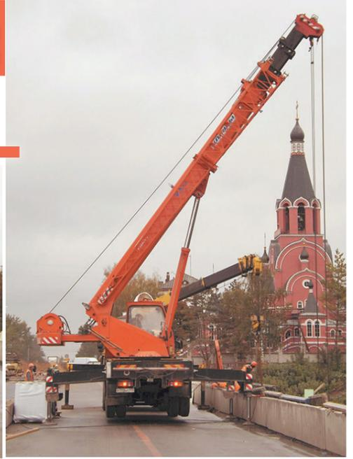
для чего, в частности, используется автомобильный кран. Во время работы он перекрывает сразу обе полосы, так что иного варианта, как вы понимаете, у ремонтников просто не было – мост следовало вновь закрыть. Уже в субботу, 1 октября, работы по бетонированию были завершены, с 5 числа стартует монтаж тротуарных плит – то есть начнётся непосредственное обустройство пешеходной зоны.
