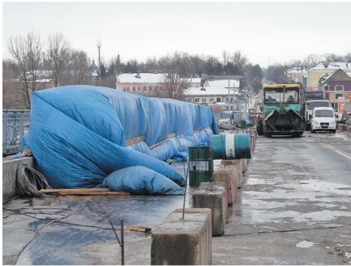
новил. Правый тротуар для движения также временно непригоден – на этом участке продолжается укладка коммуникаций кабельной канализации и монтаж новых тротуарных плит. На обоих направлениях готовятся основания под мачты постоянного освещения.
