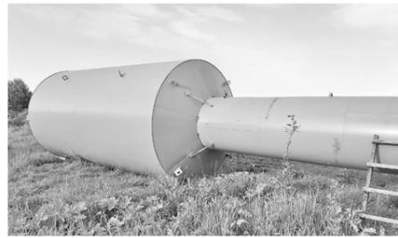
граммы поддержки местных инициатив. Металлическая труба, на которой был смонтирован накопительный бак, переломилась на глубине одного метра. С тех пор, как только отключают электричество, перестаёт работать и насосная станция, в результате население почти тысячного посёлка остаётся без водоснабжения. А водонапорная башня даже в отсутствие электроэнергии позволяет достаточно долгое время подавать воду населению.
