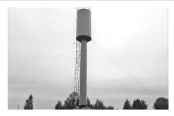
труба, на которой был смонтирован накопительный бак, переломилась на глубине одного метра. С тех пор, как только пропадает электричество, перестаёт работать и насосная станция, в результате население почти тысячного посёлка остаётся без водоснабжения.
